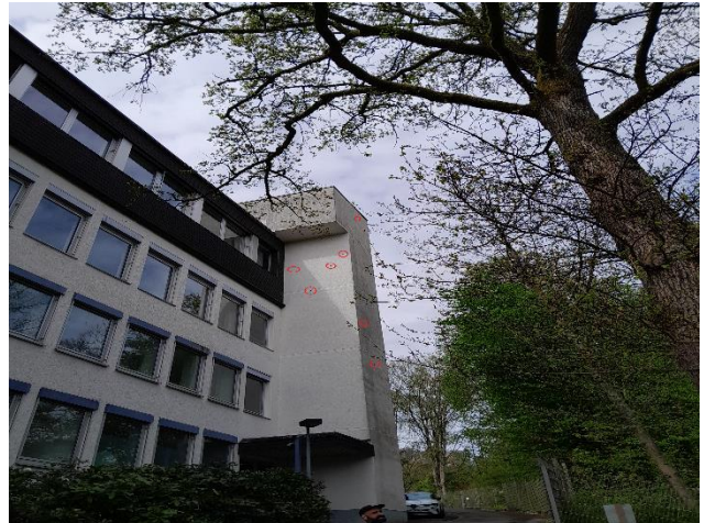
Abb. 8: Blick auf Altbau von Osten, inkl. Spechtlöcher (rot markiert) in Fassade (ISR 2025)
