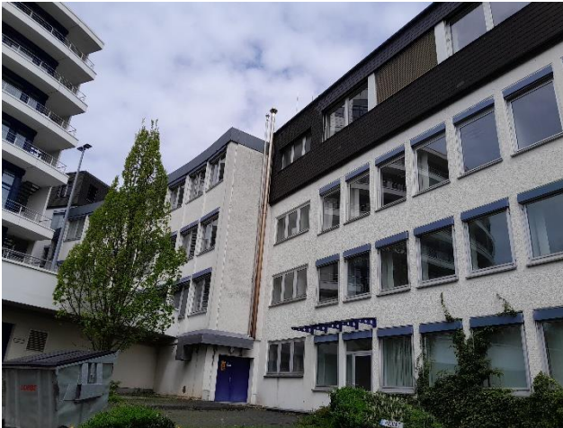
Abb. 7: Blick auf Altbau vom Inneren des Plangebietes (ISR 2025)
