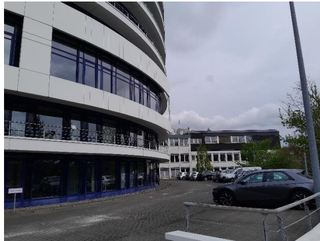
Abb. 6: Blick auf die Stellplätze im Süden des Neubaus von Westen (ISR 2025)
